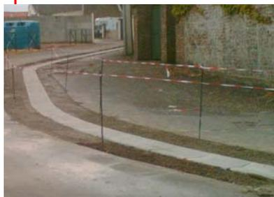
Dernier cas : la création récente d'un caniveau dans l'impasse en face de la boulangerie, ce qui a maintenant pour conséquence d'accélérer l'écoulement de l'eau sur la rue Paul Vaillant Couturier et d'en aggraver les problèmes d'inondations en cas d'orage.
